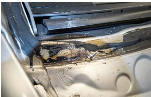
5. Gammal rost måste slipas ner tills det blir en plåten yta. Därefter läggs en primer på ytan där limmet på den nya rutan ska fästa.
