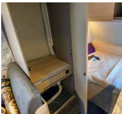
NÅGORLUNDA RYMLIG. Garderober är ganska rymlig och rören inne i den sprider värmen/kylan från klimatanläggningen.
